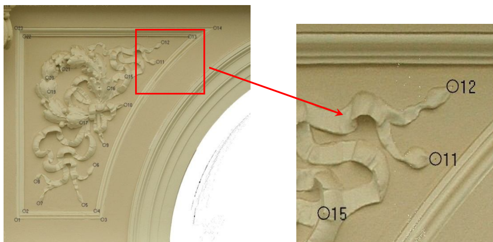
Rys. 10. Analizowany detal architektoniczny z rozkładem punktów kontrolnych.
