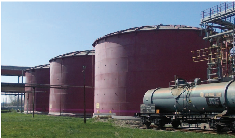
Rys. 1. Zbiorniki magazynowe kwasu – ciąg VII [foto M. Kotrys]
