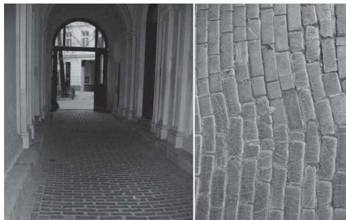
Rys. 4. Bruk drewniany z 1904 r. (foto. z pocz. lat 80. XX w., obecnie nieistniejący)
