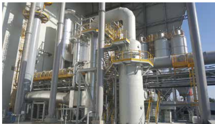
Układ odzysku ciepła ze spalin
