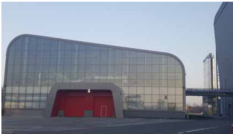
Instalacja waloryzacji żużla
