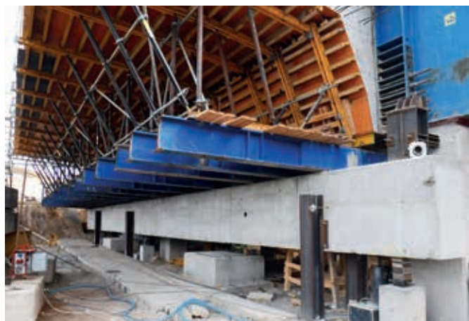
Ryc. 4. Stanowisko prefabrykacji segmentów na obiekcie MS-22
