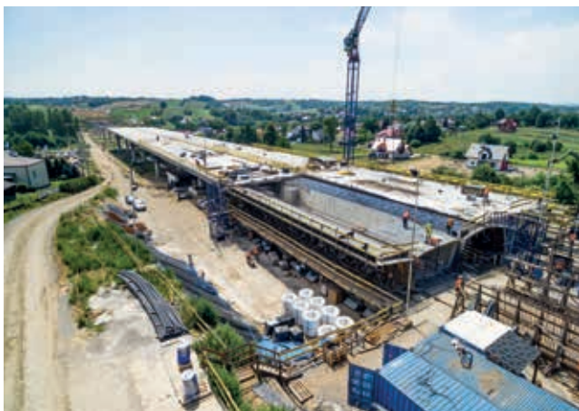
Ryc. 2. Realizację ustroju nośnego estakady E-1 podzielono na 17 etapów
