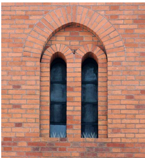
Ryc. 4. Kościół pw. św. Wincentego a Paulo, oo. Misjonarzy, fragment szczytu elewacji Fig. 4. The Church of St. Vincent a Paulo, the Missionaries, fragment of the elevation top
