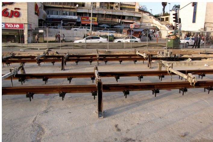
Budowa torowiska tramwajowego – budowa niektórych odcinków trwała aż półtora roku, okolice Central Station (28.03.2010 r.) Fot. A. Zaro
