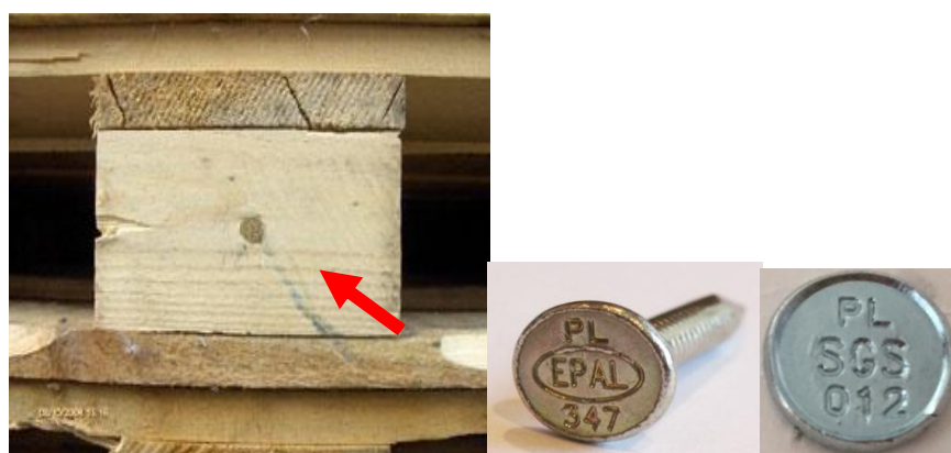
Rysunek 13. Środkowy wspornik bez oznaczeń z gwoździem certyfikującym naprawę oraz gwóźdź naprawczy do palet EPAL oraz UIC/EUR
