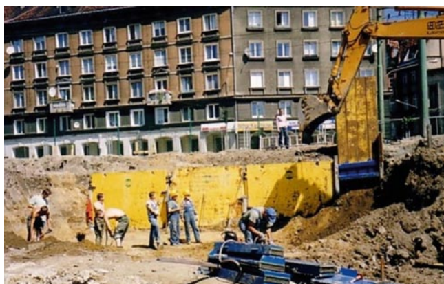
Rys. 2. Budowa jednostki ratowniczo-gaśniczej przy ul. Wolnica w Poznaniu (1997 rok); przykład mocowania płyt systemowych firmy Koproas w dwuteowych profilach stalowych
