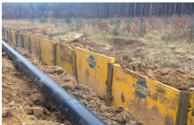
Rys. 3. Budowa gazociągu Olszyniec k. Żar, 2016 rok, z przykładem zabezpieczenia ścian wykopu z zastosowaniem płyt systemowych i słupów z profili szerokostopowych
