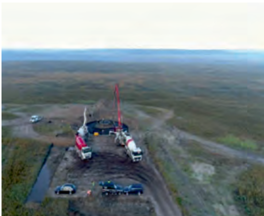
Fig. 4. Construction of Przykona wind turbine foundation [8] Rys. 4. Budowa fundamentu turbiny wiatrowej w Przykonie [8]
