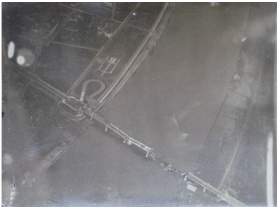
Fot. 2. Fotografia zniszczonego przez Rosjan III Mostu w Warszawie, wykonana przez niemiecką 8. połowę eskadry lotniczą w 1915 r. (zbiór autora)
