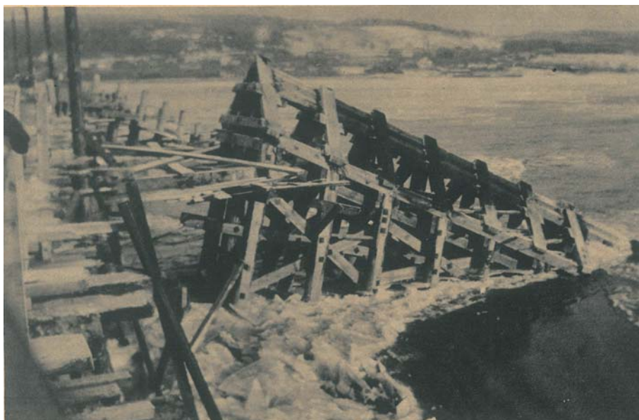
Fot. 11. Budowa izbicy mostu we Włocławku przed pochodem lodów, na fotografii z Eine Bilderreihe aus der Zeit des Weltkrieges , G. Stalling, Oldenburg 1918 (zbiór autora)
