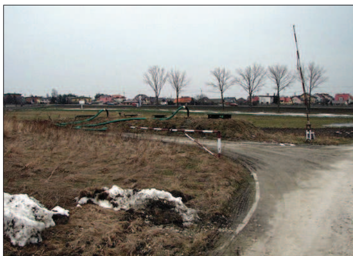
Fot. 1. Składowisko odpadów poprodukcyjnych w Tłokini Kościelnej k/ Kalisza. Widoczne włązy zbiorników stalowych na odcieki. Marzec 2013r., fot. Zb. Staszewski
