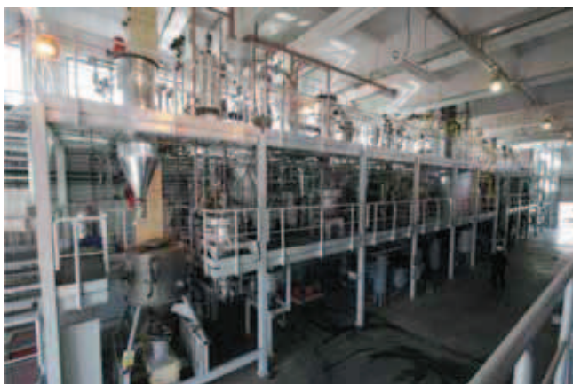
Rys. 3. Instalacja ciśnieniowego zgazowania węgla w reaktorze z cyrkulującym złożem fluidalnym. Hala technologiczna CCTW, Instytut Chemicznej Przeróbki Węgla
