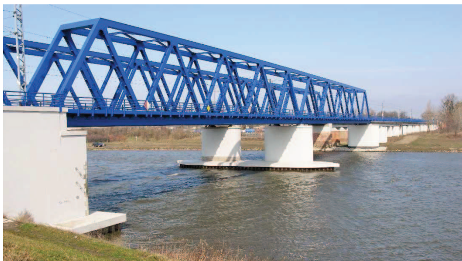
Rys. 6. Most nad Odrą we Wrocławiu. Widok na przęsła nurtowe – tor nr 1 (po przebudowie)
