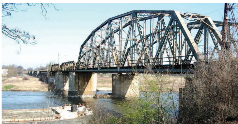
Rys. 1. Most nad Odrą we Wrocławiu. Widok na przęsła nurtowe – tor nr 2 (przed przebudową)
