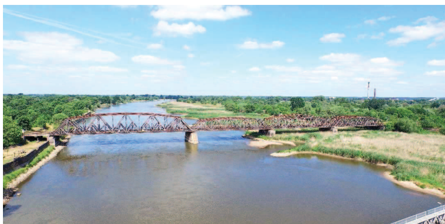
Rys. 18. Most nad Odrą w Kostrzynie. Widok na konstrukcję (stan istniejący)
