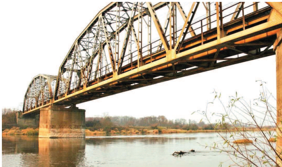
Rys. 15. Most nad Bugiem. Widok na konstrukcję – tor nr 2 (stan istniejący)
