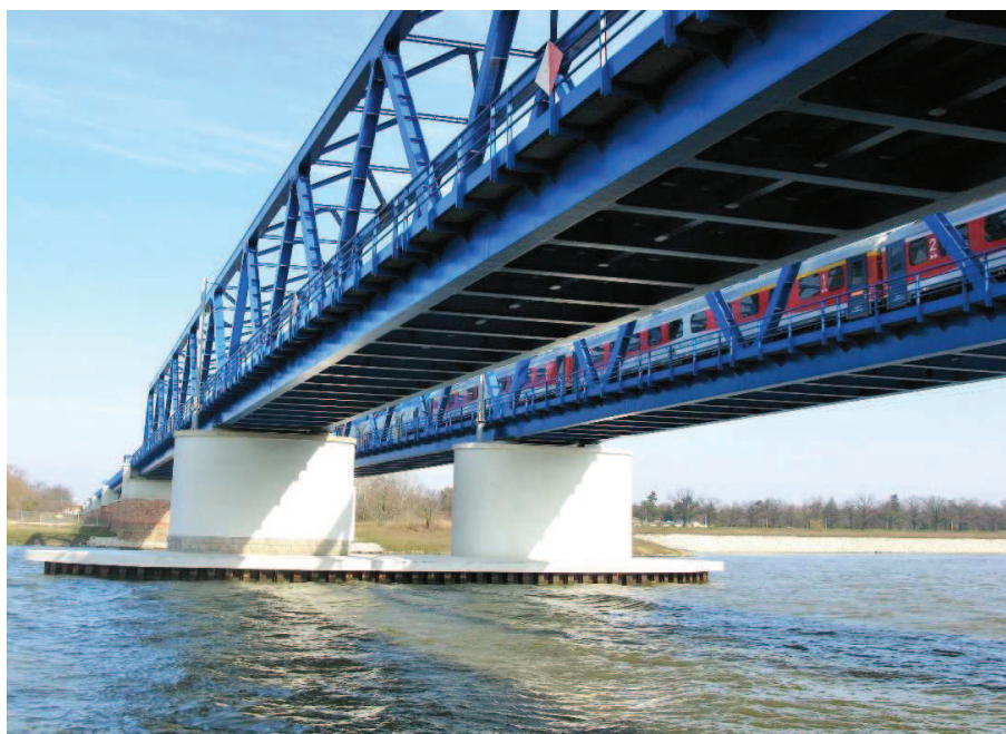
Rys. 7. Most nad Odrą we Wrocławiu. Widok na przęsła nurtowe (po przebudowie)
