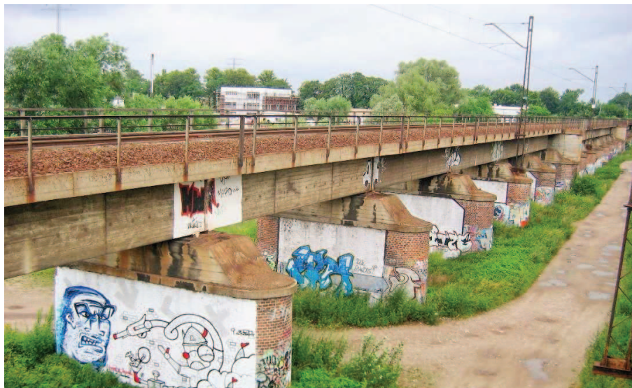
Rys. 2. Most nad Odrą we Wrocławiu. Widok konstrukcji nad terenem zalewowym – tor nr 2 (przed przebudową)
