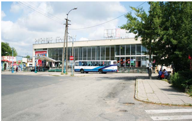
Fot. 2. Dworzec kolejowo-autobusowy w Płocku przed przebudową. Fot. D. Załuski
