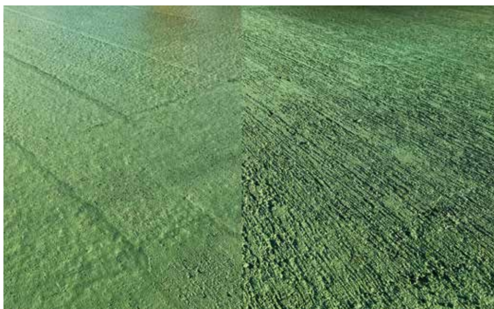
Fot. 6. Powierzchnia betonu przed i po nadaniu faktury
