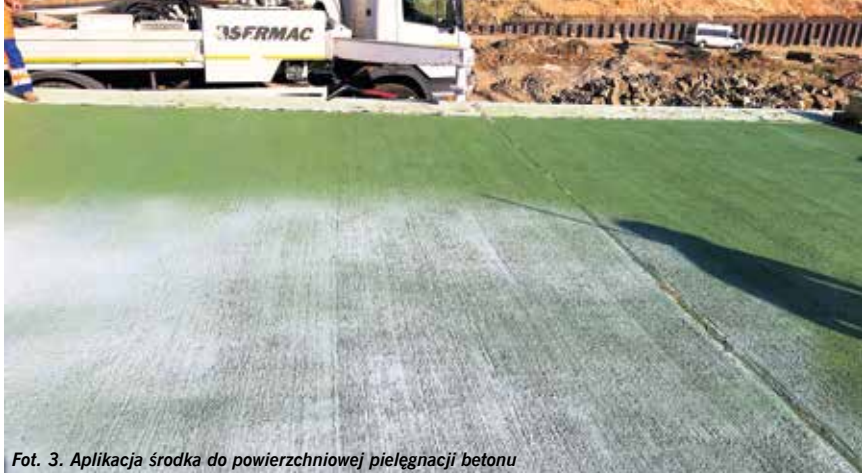
Fot. 3. Aplikacja środka do powierzchniowej pielęgnacji betonu
