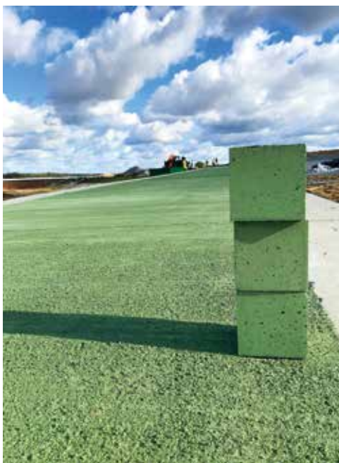
Fot. 3. Aplikacja środka do powierzchniowej pielęgnacji betonu
