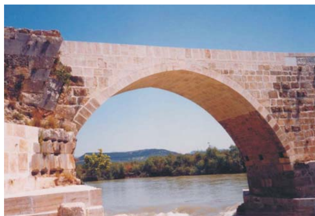
Ryc. 2. Teraźniejsze i starożytne elementy trawertynowe mostu w Belkis (Turcja). Fot. J. Pinińska
