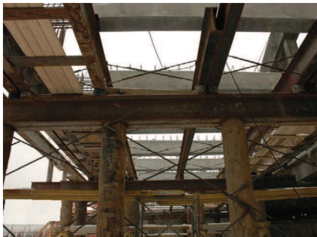
Rys. 6. Stalowe podpory pośrednie pod każdym przęsłem wznoszonego mostu
