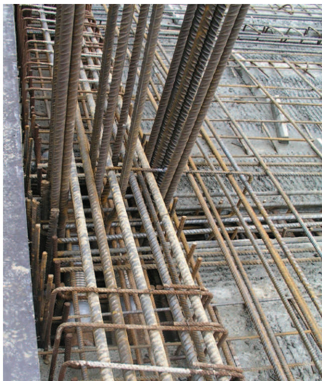
Rys. 8. Zbrojenie miejsca uciąglenia kanałów belek sprężonych
