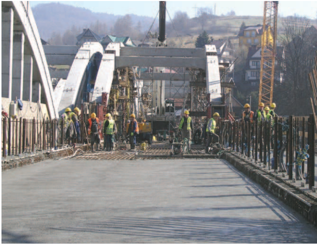
Rys. 10. Betonowanie zespolonej płyty mostu
