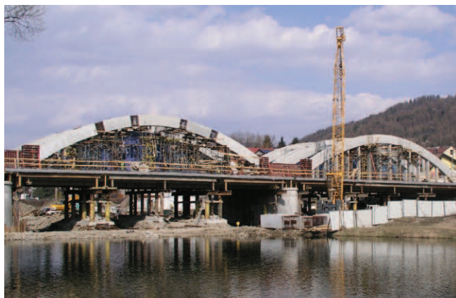
Rys. 14. Widok prefabrykowanej konstrukcji łuków
