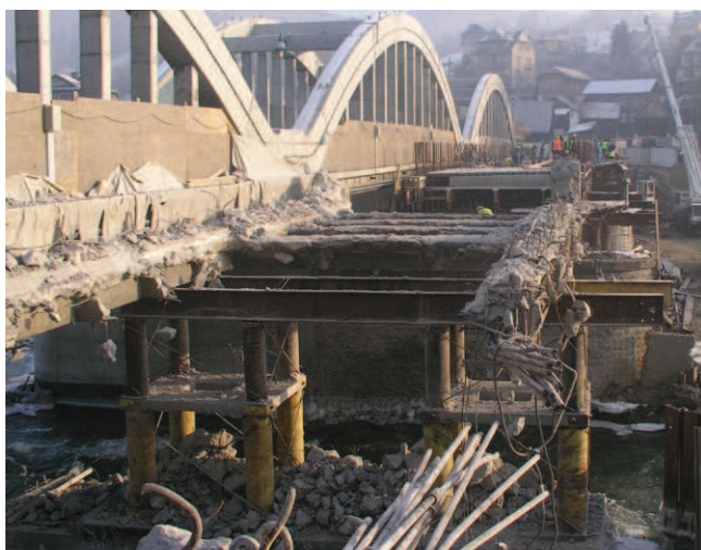
Rys. 5. Demontowanie konstrukcji pomostu przęsła nad korytem rzeki Dunajec
