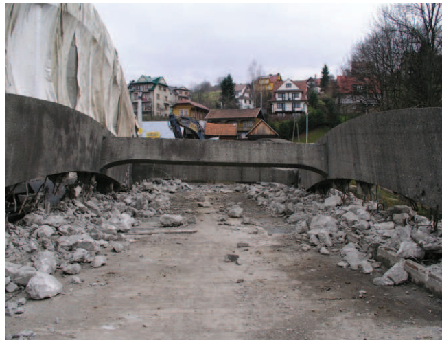
Rys. 3. Widok zdemontowanych dźwigarów łukowych mostu
