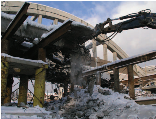
Rys. 4. Demontowanie konstrukcji pomostu (przęsło środkowe)
