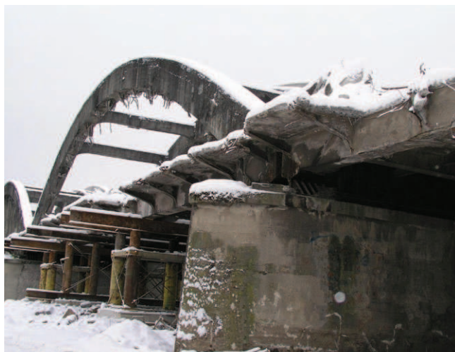
Rys. 2. Widok konstrukcji mostu po demontażu wieszaków
