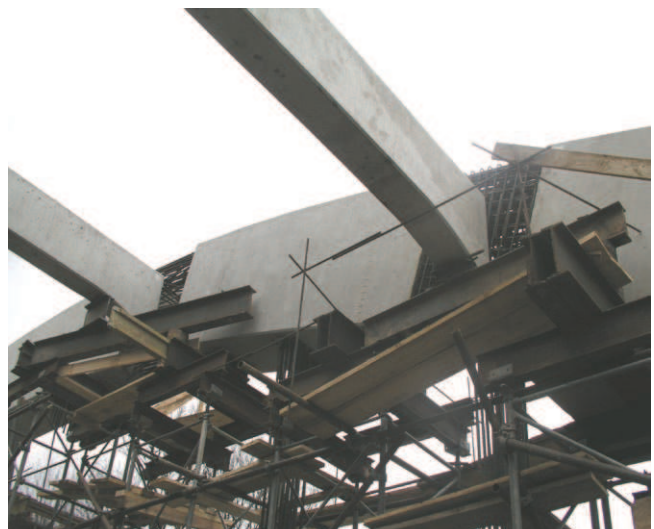
Rys. 13. Połączenie prefabrykowanych elementów łuków ze stężeniem
