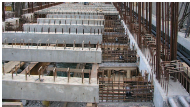
Rys. 7. Rozmieszczone elementy prefabrykowane mostu
