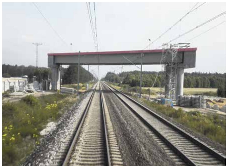
Budowa wiaduktu drogowego w celu likwidacji przejazdu w poziomie szyn w km 129,357 (czerwiec 2013 r.)
