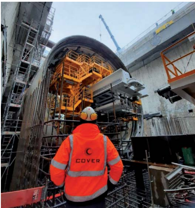
Fot. 3. Montaż systemu drążącego TBM w komorze startowej [3]
