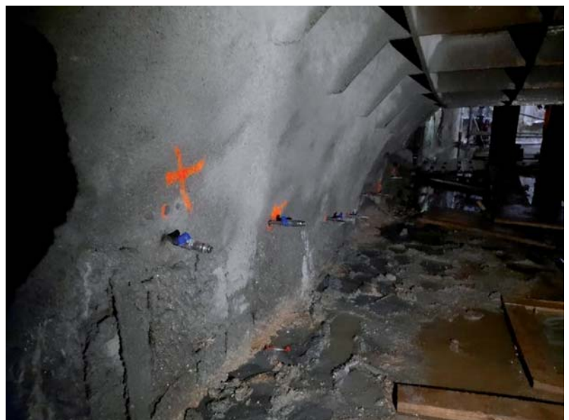
Fot. 4. Osadzone pakery iniekcyjne w pierwszym etapie prac w ścianie komory startowej TBM
