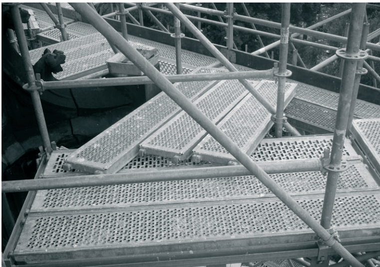
Rys. 4. Przykład uzupełnienia powierzchni pomostu roboczego przerwami
