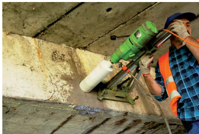
Fot. 1. Pobieranie rdzenia betonu z oczepu filara
