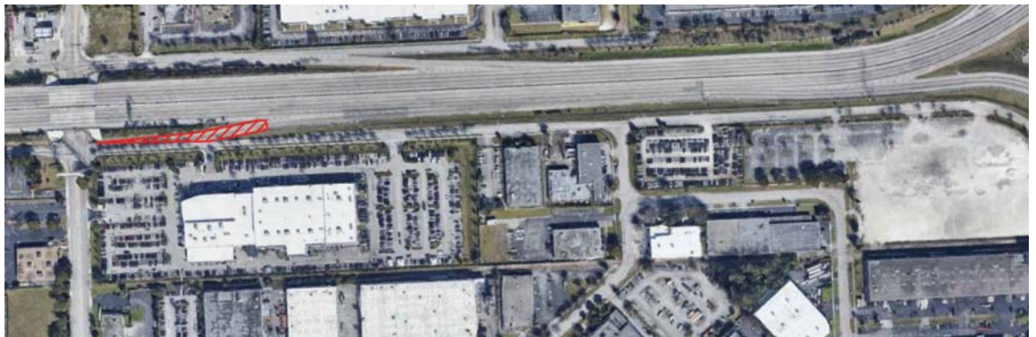
Fot. 2. Usuwana łącznica z drogi serwisowej nr 167 na obwodnicę SR 826. Źródło: własne
