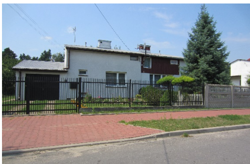
Ryc. 9. Budynek mieszkalny w oryginalnym gabarycie (z powiększonym jedynie garażem) na osiedlu Praca, pod adresem ul. Walecznych 12. Źródło: zdjęcie autora (2015 r.)
