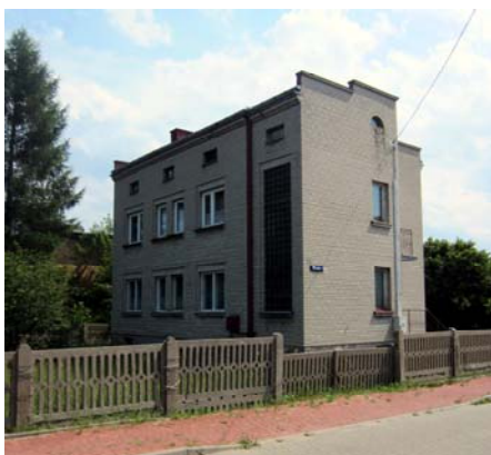
Ryc. 11. Budynek mieszkalny na osiedlu Bór, pod adresem ul. Nowa 24. Źródło: zdjęcie autora (2015 r.)
