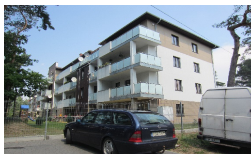
Rys. 14. Budynek mieszkalny na osiedlu Bór pod adresem ul. Nowa 24. Źródło: zdjęcie autora (2015 r.)
