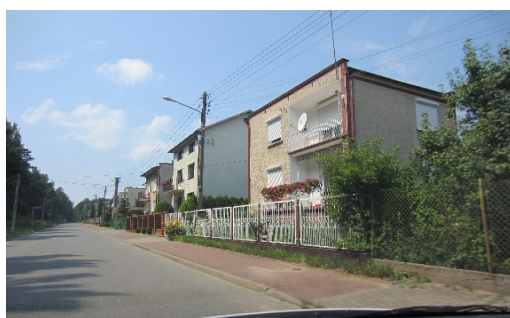
Rys.13. Zróżnicowanie zabudowy wzdłuż jednej ulicy. Widoczne zróżnicowanie elewacji, dachów, układu otworów okiennych. Źródło: zdjęcie autora (2015 r.)
