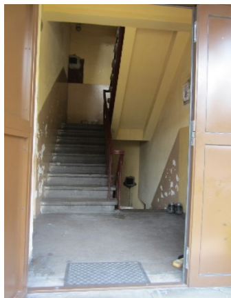
Ryc. 22. Klatka schodowa w domu mieszkalnym na osiedlu Staffa. Źródło: zdjęcie autora (2015 r.)
