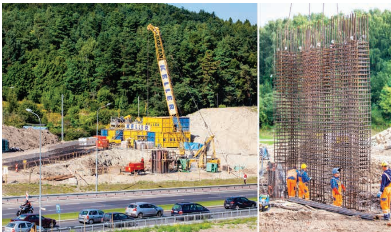
Ryc. 12. Realizacja głębokiego posadowienia podpory P1
