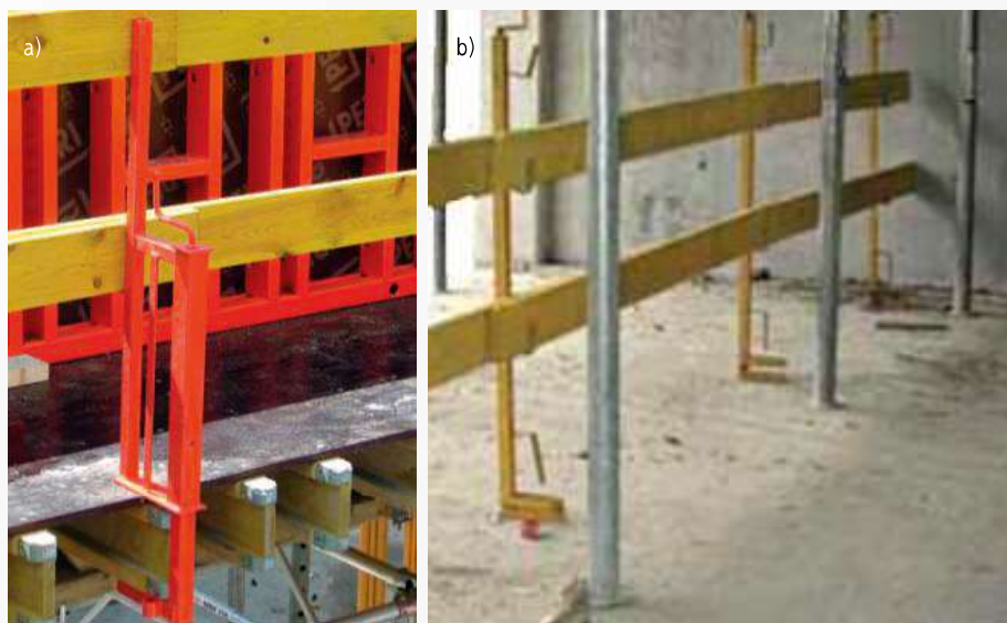
Fot. 1. Balustrady ochronne mocowane do stropu za pomocą: a – systemu szczękowego, b – specjalnych uchwytów (Fot. archiwum CIOP-PIB)
