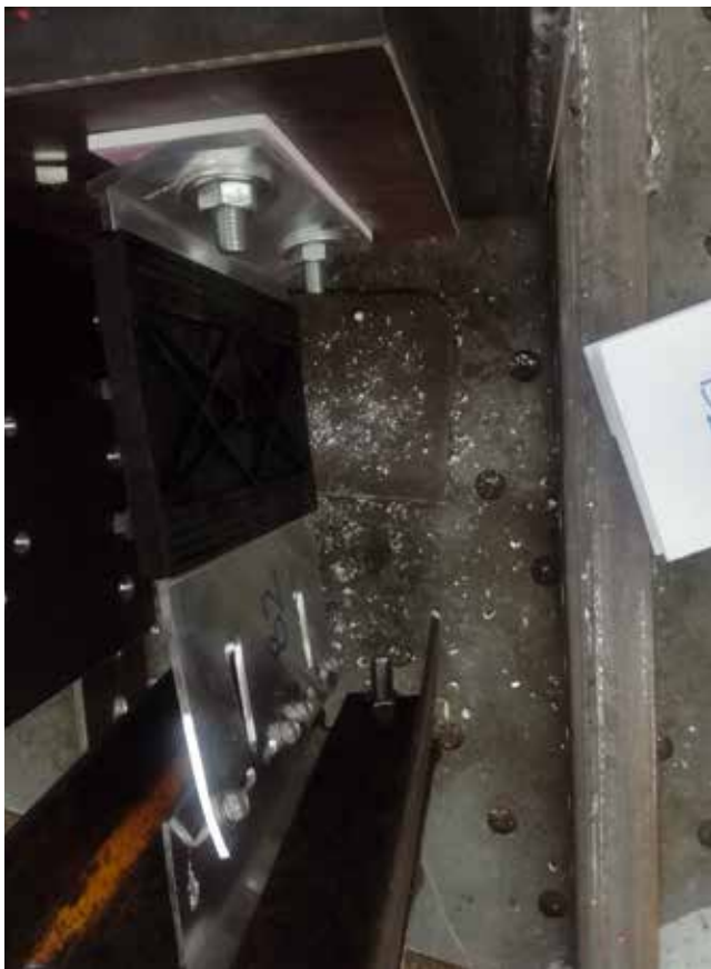
Rys. 15. Odsztącenia uzyskane w ramach badań laboratoryjnych dla zakotwienia skrajnie do zewnątrz; źródło: autor
