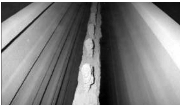
Rys. 1. Nagromadzony pył na elektrodach zbiorczych i ulotowych [7]
