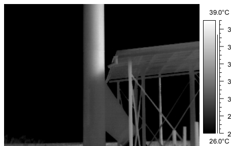
Rys. 7. Termogram kominia częściowo zacienionego Fig. 7. Thermogram of a partially shaded chimney
