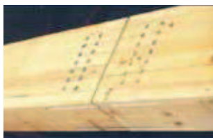
Rys. 1. Sworzniowe połączenie drewniane z wewnętrznymi płytami stalowymi
