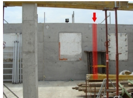
Rys. 2. Słup żelbetowy w systemie Polytech – lokalizacja czujników
