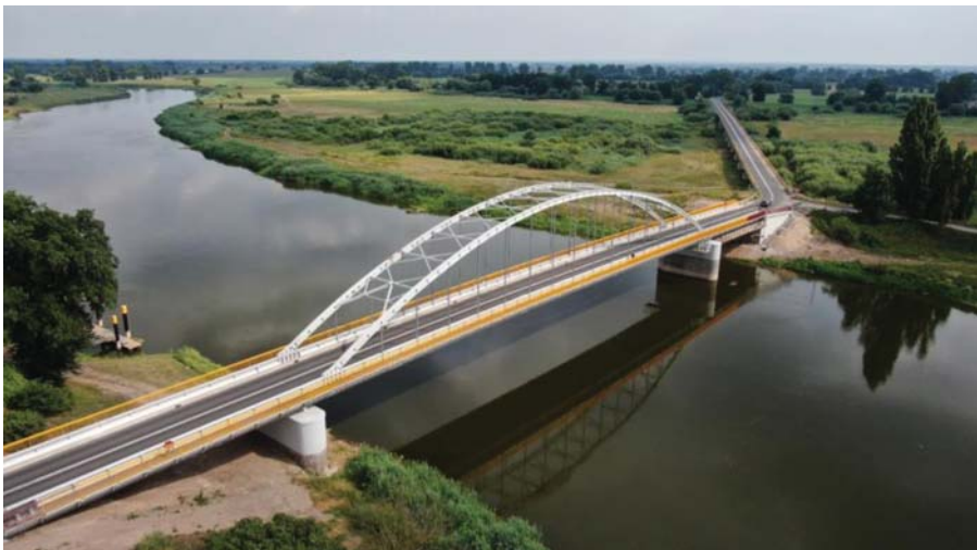
Fot. 8. Obiekt po oddaniu do użytkowania; widok z prawego brzegu, w tle część zalewowa mostu
