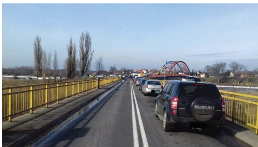
Fot. 7. Dziesiątki pojazdów zaparkowanych na przęsłach zalewowej części mostu [10]
