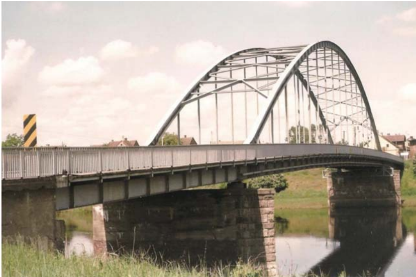
Fot. 2. Widok ogólny mostu z lewego brzegu rzeki Warty (lata 90. XX w.)
