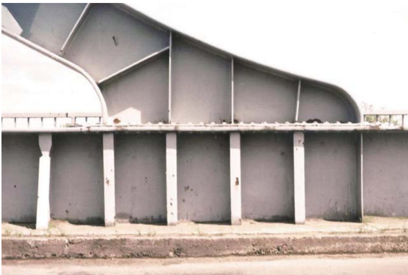
Fot. 3. Miejsce nitowanego połączenia łuku wiotkiego z górnym pasem blachownicowej belki głównej
