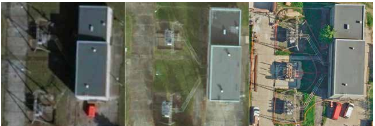
Porównanie dwóch nieaktualnych i gorszej rozdzielczości ortofotomap z wyraźną i najnowszą z 2019 r. (po prawej)
