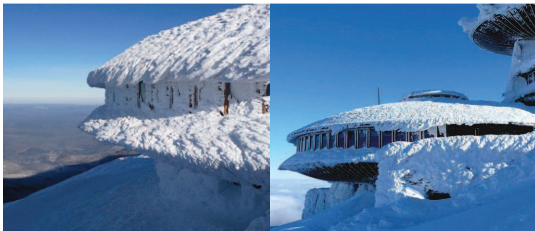
Rys. 7. Spodek dolny – obciążenie śniegiem (źródło IMGW – Wrocław)
