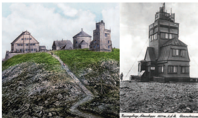
Rys. 1. Zabudowania na Śnieżce 1900 r. Budynek starego obserwatorium (źródło: internet)
