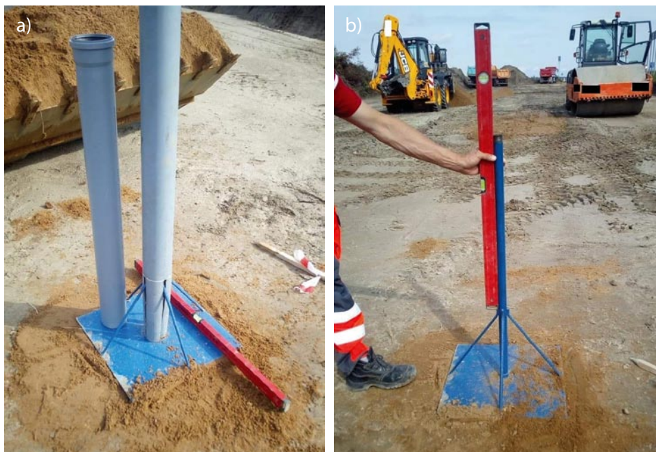
Rys. 4. Montaż systemu monitoringu geotechnicznego
