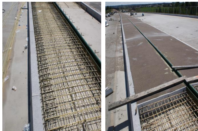
Rys. 1. Zbrojenie CFRP i BFRP zabudowy chodnikowej mostu w ciągu drogi S1 Olsztyn Wschód – Olsztyn Południe [8]
