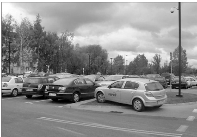
Fot. 7. Mała wyspa obsiana trawnikiem, źle zabezpieczona, często staje się nieformalnym miejscem postoju samochodów (fot. A. Sarna, październik 2008; CH Faktory Ursus)
