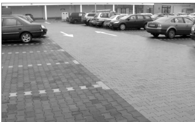
Fot. 10. Kolorowa, jasna kostka betonowa na parkingu pozwala na rozróżnienie stanowisk postojowych i drogi dojazdowej (fot. A. Sarna, styczeń 2009; Ikea–Targówek)
