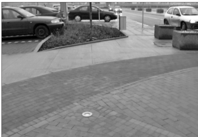
Fot. 9. Ciagi piesze wyróżnione poprzez kompozycję różnokolorowych kostek Bauma i płyt betonowych (fot. A. Sarna, styczeń 2009; Ikea – Targówek)
