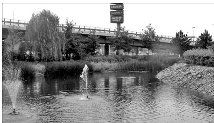
Fot. 13. Jeden ze zbiorników retencyjnych przy Ikea – Targówek, obsadzony roślinnością, zaopatrzone w dysze wygląda jak piękny staw (fot. A. Sarna, październik 2008)
