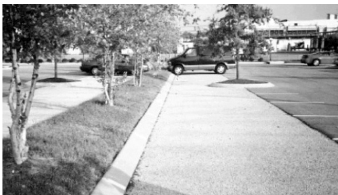
Fot. 11. Jasny, porowaty beton wygląda estetycznie i jest przyjazny dla środowiska źródło: www.mississippiconcrete.com/pervious_gallery.cfm
