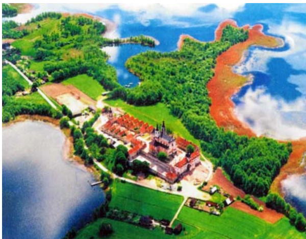
Ryc. 1. Zdjęcie lotnicze klasztoru z kościołem, Domem Królewskim i Kaplicą Kanclerską z przodu i eremami na dalszym planie (fot. W. Wolkowa, 2005) Fig. 1. Aerial view of monastery with the church, the Royal House and the Chancelor's Chapel in the foreground and the erem in the background (photo W. Wolkowa, 2005)
