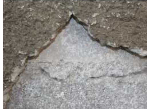
Fot. nr 2 i 3 – Widoki elewacji budynku w rejonie odkrytych warstw tynkarskich
