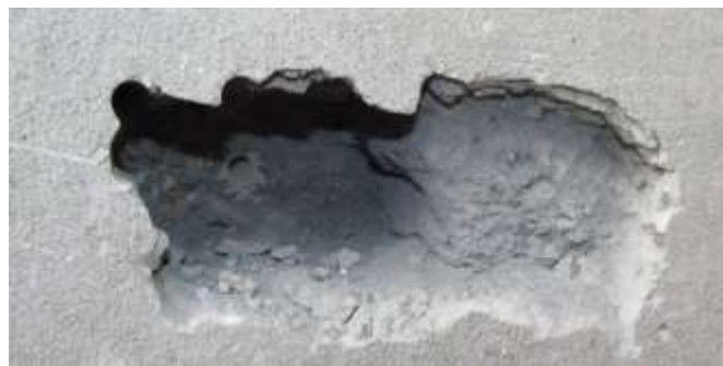
Fot. nr 4 – Widok odkrywki struktury ściany w miejscach gładkiego tynkowania.
