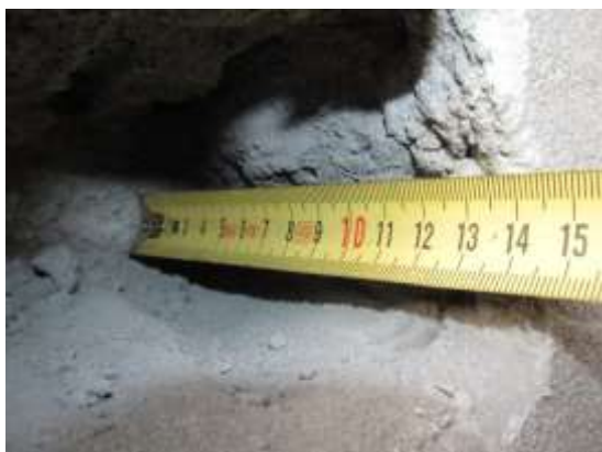
Fot. nr 5 – Widoki pomiaru kontrolnego grubości poszczególnych warstw wykończeniowych
