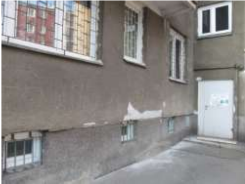
Fot. nr 2 i 3 – Widoki elewacji budynku w rejonie odkrytych warstw tynkarskich
