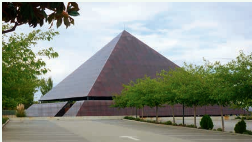
Ryc. 2. Piramida solarna zasilająca w energię elektryczną pojazdy transportujące ludzi w nowo wybudowanym parku przy centrum kongresowo-wystawienniczym Feria de Madrid
