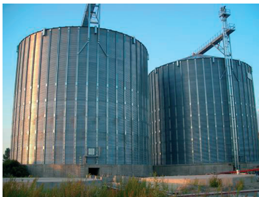
Rys. 1. Stalowe silosy na zboże
