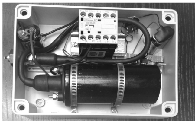
Rys. 5. Złożony generator impulsów testowych
