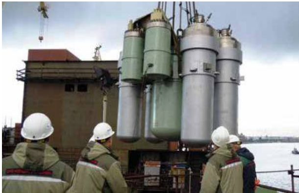
Fot. 4. Przenoszenie modułu reaktora KLT-40S (reaktor, wytwornice pary, pompy obiegu chłodzenia, stabilizatory ciśnienia) na barkę (fot. Rosenergoatom – WNA)
