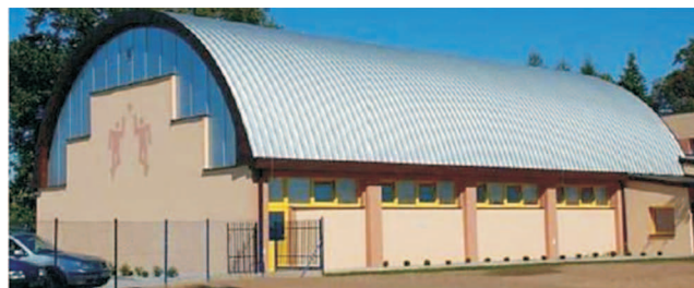
Rysunek 3 Hala sportowa wykonana w technologii ABM
