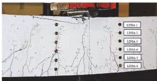
Rys. 6. Widok belki ze zbrojeniem HFRP przy obciążeniu 66,0 kN
