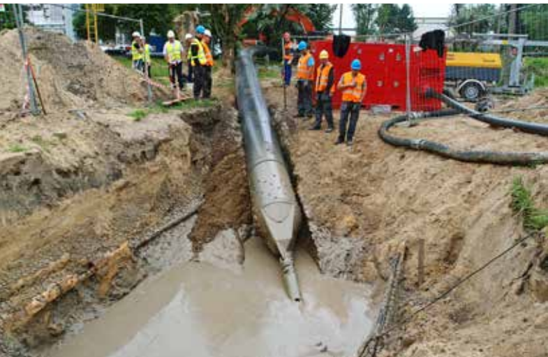
Przewiert horizontalny (HDD) rurą PE-HD WehoPipe DN 800, fot. Uponor Infra Sp. z o.o.
