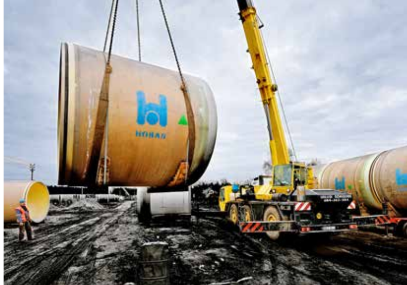
Rura CC-GRP HOBAS OD 3000, kolektory dosyłowe do Oczyszczalni Ścieków „Czajka”, fot. HOBAS System Polska Sp. z o.o.
