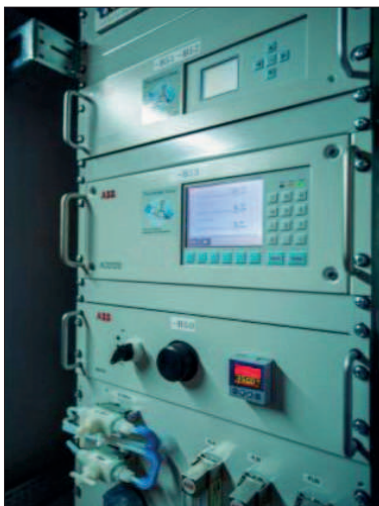
Rys. 7c. Stacjonarny system do ciągłej analizy składu gazów odlotowych produkcji firmy ABB
