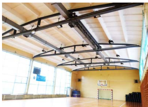
Rys. 4. Widok monitorowanych dźwigarów przekrycia dachowego hali sportowej w Krakowie oraz schemat rozmieszczenia punktów pomiarowych.
