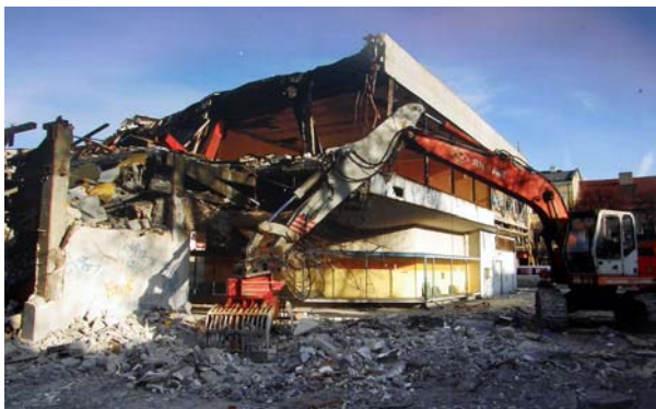
Ryc. 8. Oświęcim. Rynek Główny. Wyburzenie pawilonu „Tęcza”. Materiały informacyjne UM Oświęcim Fig. 8. Oświęcim. Main Square. Demolishing the “Tęcza” pavilion. Information materials of the MO Oświęcim
