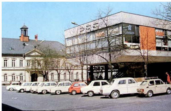
Ryc. 6. Oświęcim. Dom Handlowy „Tęcza”. Widok na wbudowany bunker. Kartka pocztowa z 1975 r., wyd. KAW „Ruch”, ze zbiorów autora
