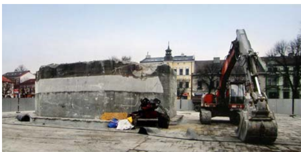
Ryc. 9. Oświęcim. Rynek Główny. Wyburzenie bunkra niemieckiego w ramach projektu przebudowy płyty rynku, 2010 r. Materiały informacyjne UM Oświęcim Fig. 9. Oświęcim. Main Square. Demolishing the post-German bunker within the project of rebuilding the market square, 2010. Information materials of the MO Oświęcim
