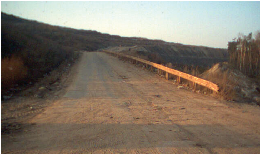
Rys. 1. Droga wjazdowa na szczyt składowiska Łubna
